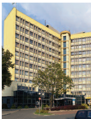
Urząd Miasta, Tychy Rozdzielnica główna na prąd znamionowy 1600 A z zaawansowanym układem automatyki SZR.
