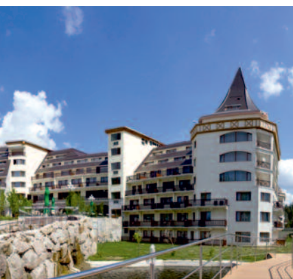
Hotel Gołębiewski Karpacz Rozdzielnice główne na prąd znamionowy 2500 A z zaawansowanym układem automatyki SZR i sterowania zdalnego.
