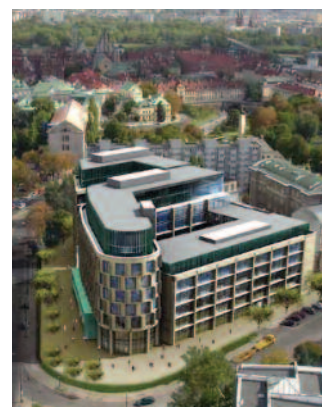
Biurovec Senator, Warszawa Rozdzielnica główna na prąd znamionowy 2500 A i pomocnicze na 1600 A.
